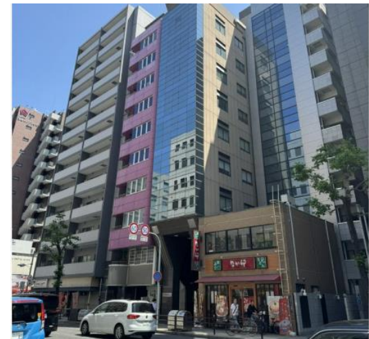
▲大阪心斎橋オフィス
